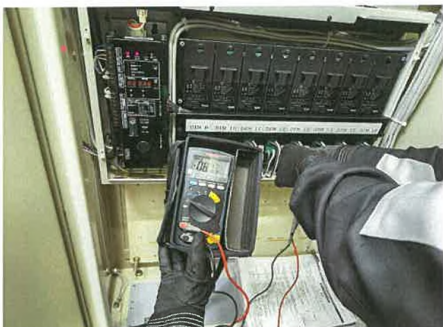
調光装置 信号電圧測定
