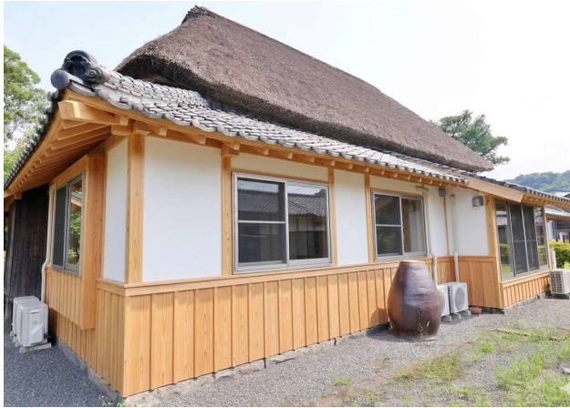
縦羽目板張り目板打ちの外壁
