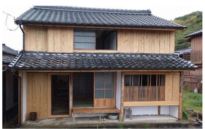
漆喰塗りと板張りの外壁
