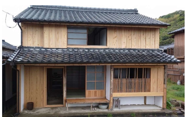
漆喰塗りと板張りの外壁
