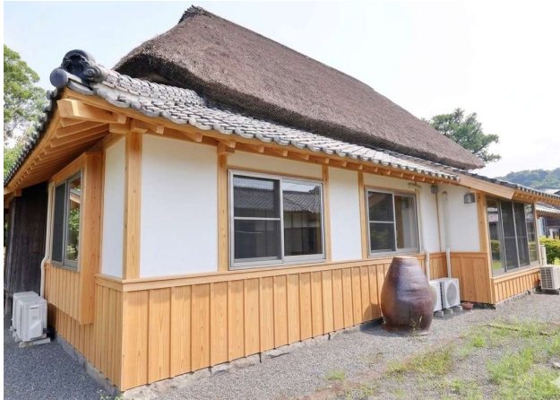
豎羽目板張り目板打ちの外壁
