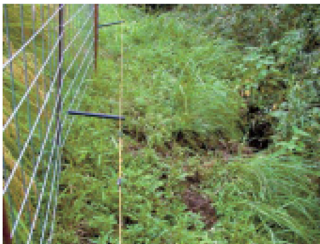
溶接金網柵と電気柵を組み合わせた例 (高知県中土佐町)
