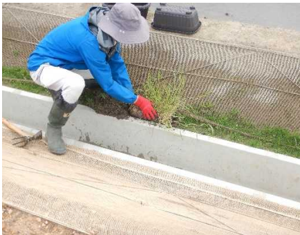
工事完了区域内でのミズタカモジグサの定植状況 (R7.4.8)
