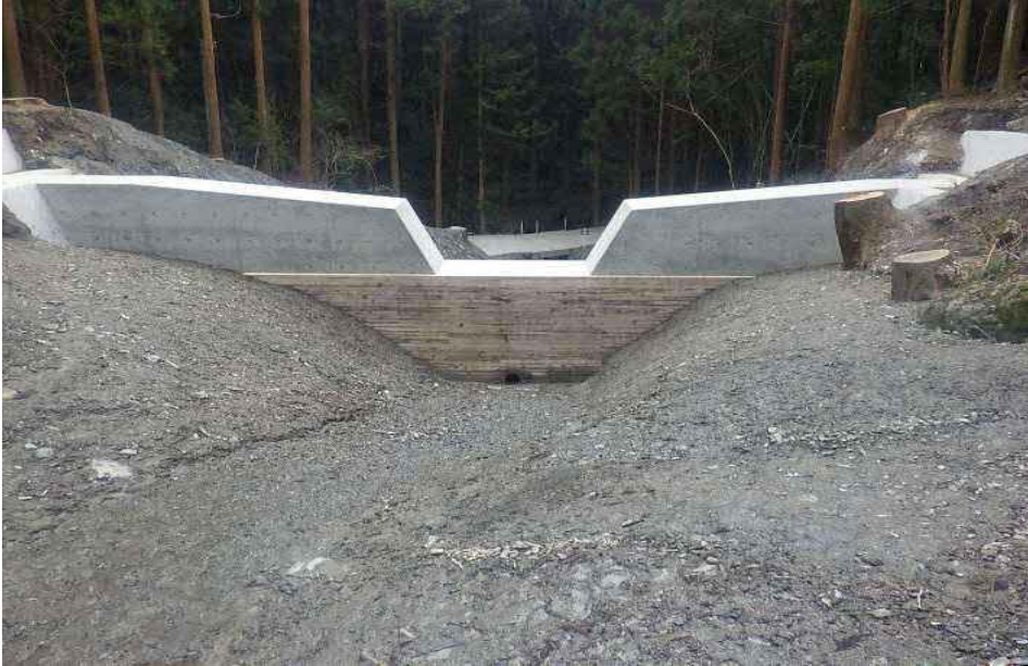
木製残存裏型枠 (サバイバルウッド)
