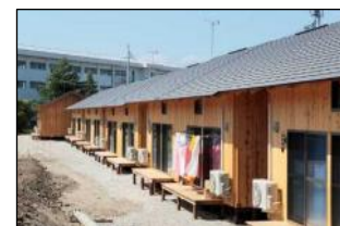
応急仮設住宅
