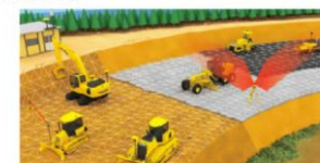
・3次元測量データに基づくICT建機による施工 ・安全性と生産性の向上
