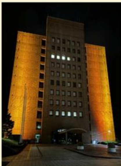
【県庁舎をオレンジ色のライトアップ】
