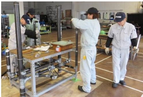
排水設備の組立実習
