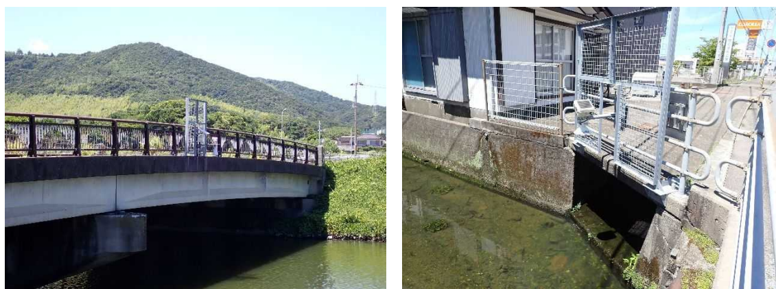
写真 4-2 危機管理型水位計設置状況
