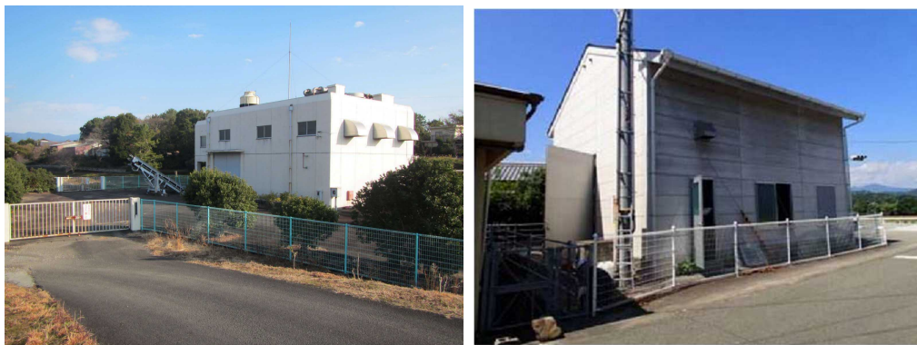
写真 4-2 排水機場の状況（左：善蔵川排水機場、右：海部川排水機場）
