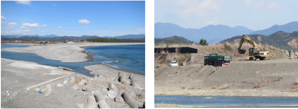
写真 4-1 砂州の維持掘削
