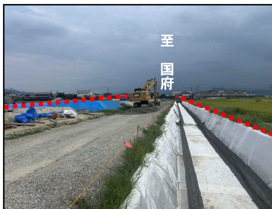
写真① 官民境界部の擁壁工事状況
