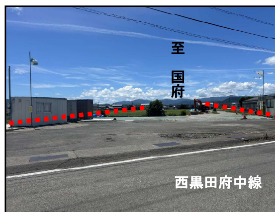
写真② 西黒田府中線との接続位置工事状況
