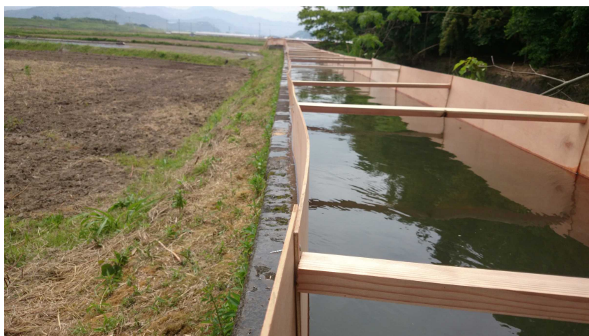
図 4 - 6 合板で応急処置を行った水路
