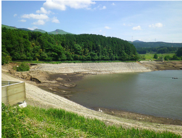
図４－７ 緊急的に水位を下げたため池
