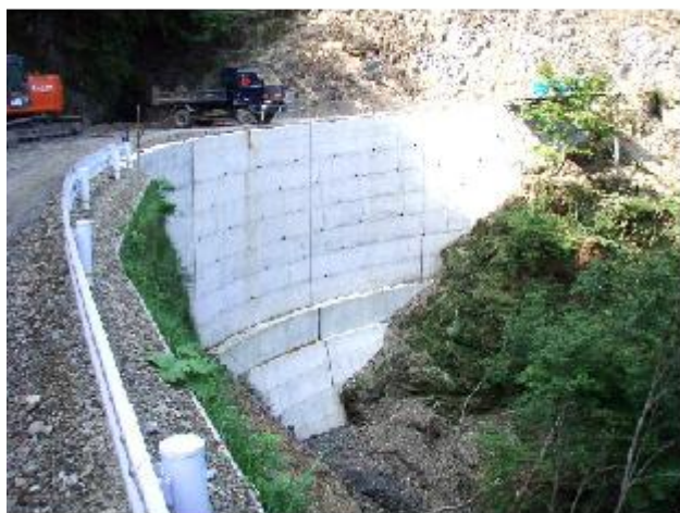
コンクリート擁壁工
