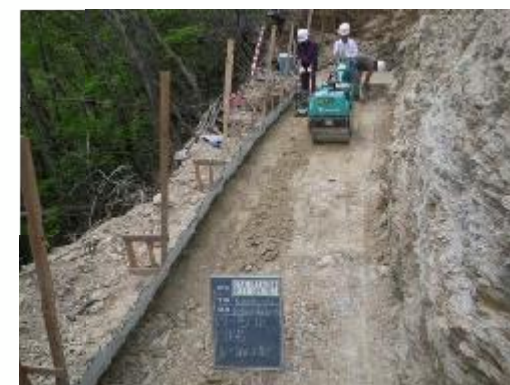
切取り土砂投入締固め
