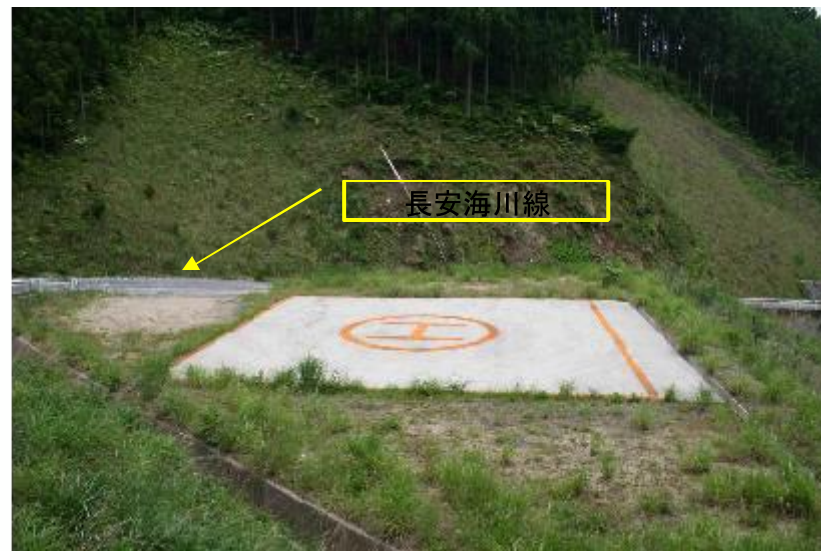
⑧ 災害時のヘリポート施設
