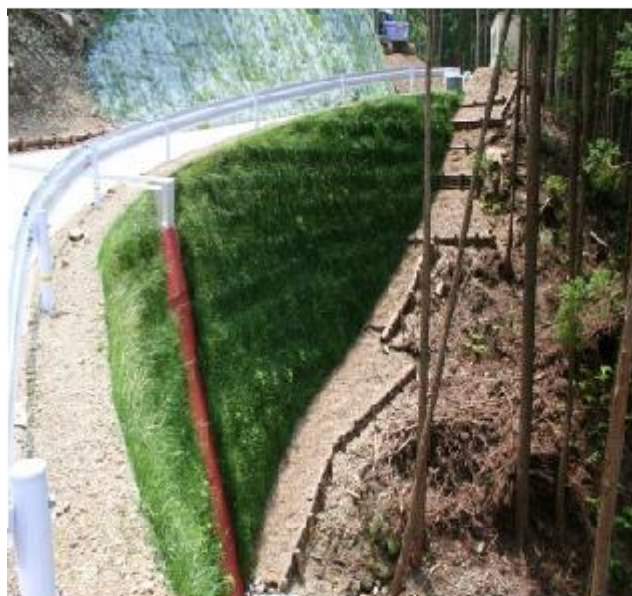
補強土壁工 完 成
