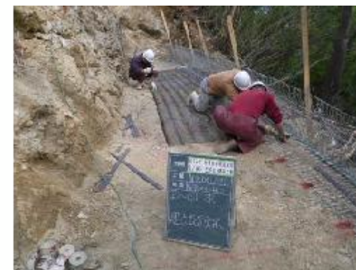
補強材の設置
