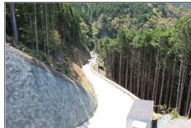
⑦ 平成23年度施行部分の状況
