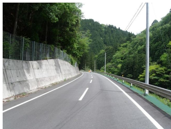
現道拡幅区間 (H21. 3月部分供用)
