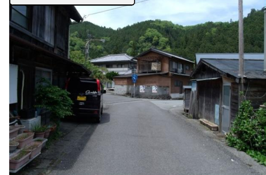
海川トンネル
