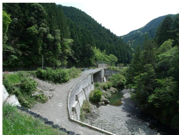
1号トンネル終点側坑口付近施工状況
