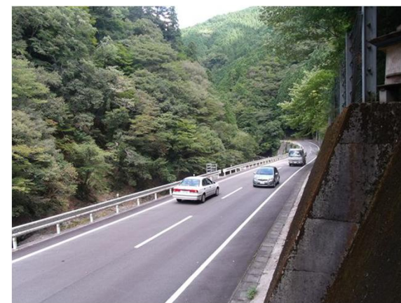
現道拡幅区間 (H21. 3月部分供用)
