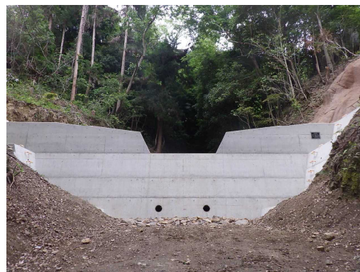
治山施設の整備
