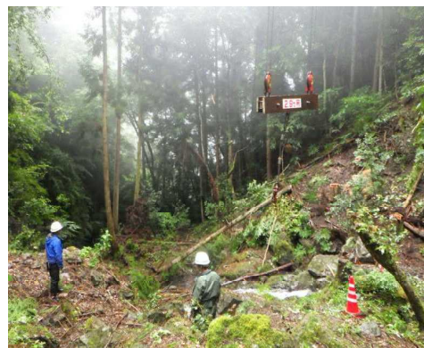
溪流内の危険木の除去
