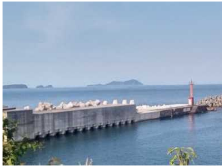
防波堤の耐津波化対策 (鞆奥漁港)
