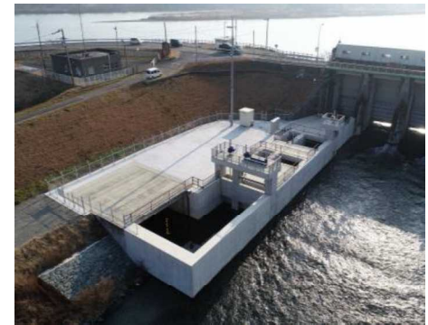
第十取水口整備
