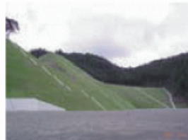
吹き付け工法
