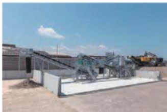
中間処理施設
