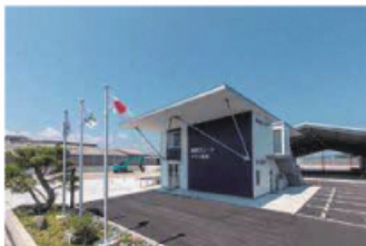
(有)ヤマト重機 徳島営業所
