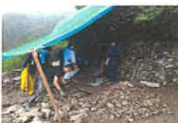
①高開石積みの修復作業
