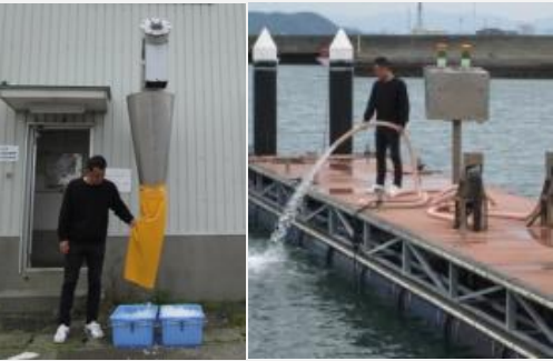
【整備後】 ・自動送氷による、省力化や操業機会の確保 ・規格：鉄骨造2階建、製氷5t/日、貯氷10t
