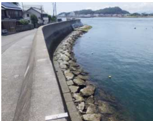
堤防の高潮対策(護岸補強前) (鳴門市土佐泊漁港海岸)
