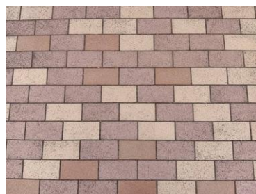
通行可能な舗装通路
