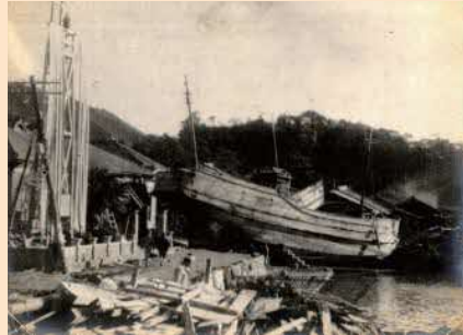
●「牟岐町、道路に押し上げられた漁船」(気象庁ホームページより)
