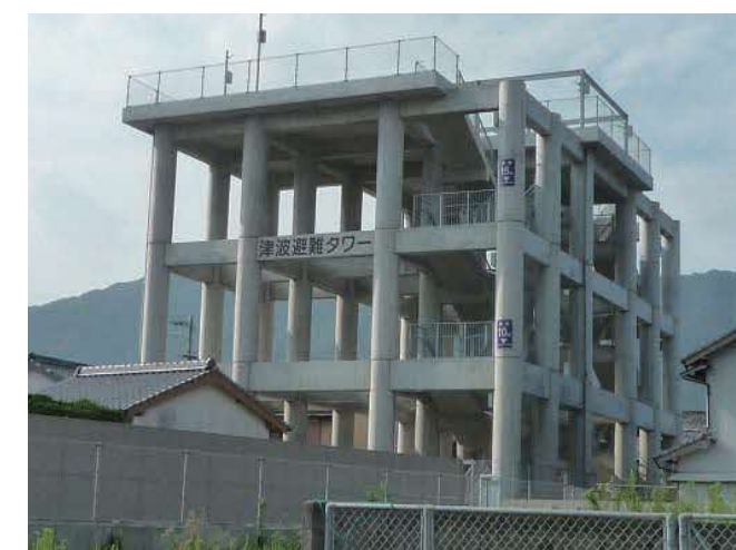
穴喰津波避難タワー(海陽町穴喰)
