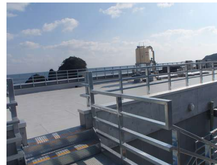
▲屋上は海拔18m（津波想定最大波高9m）の高度があり、貯水タンクから飲み水を確保できます
