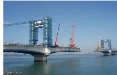
写真-7 トラバークレーン張出架設
