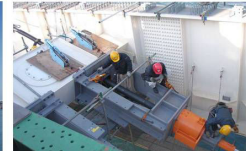
写真-8 仮設ケーブル引込み
