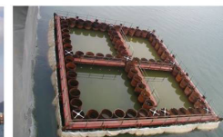
写真-2 鋼管矢板井筒施工後
