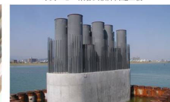
写真-4 鋼管複合橋脚施工状況
