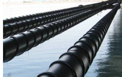
写真-12 ケーブル制振対策 ヘリカルワイヤ
