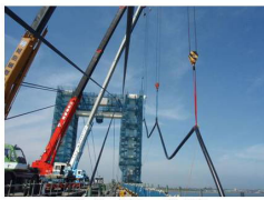
写真-8 本設ケーブル架設
