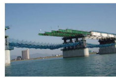
写真-5 送出し架設 (P7~P10)
