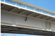
写真-11 耐風対策 (700mm×200mm×10mm 水平板、横構)
