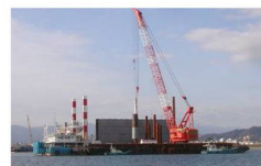
写真-1 鋼管矢板打設状況 (P2・P3)
