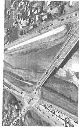
園瀬川堤防の補強対策が実現
