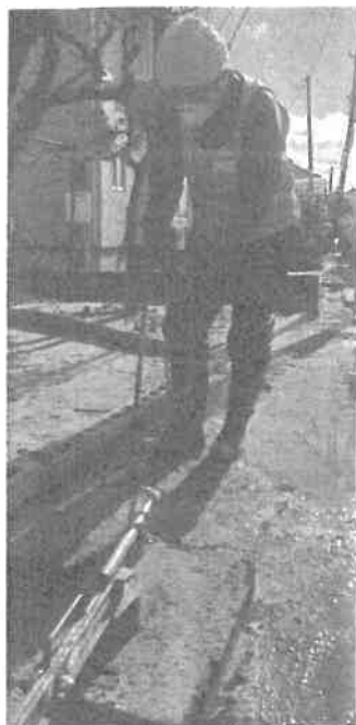
新潟市の住宅地で液状化で噴き出した砂で埋まった側溝の清掃作業
