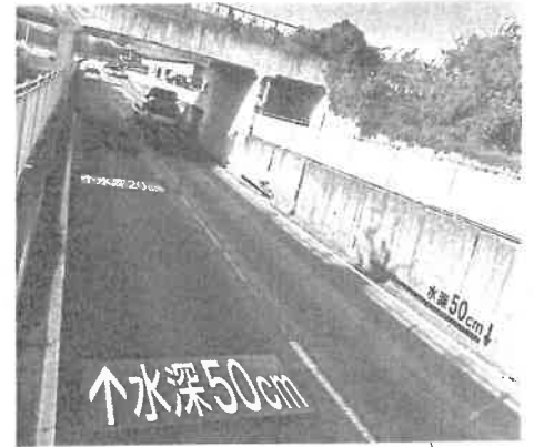
川島・県道板野川島線 (冠水対策の水深表示新設)
