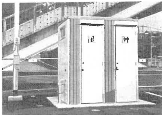
完成したJR阿波川島駅トイレ
