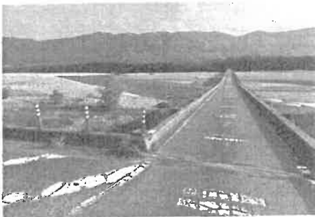
川島・学島潜水橋 (安全ポール修繕)
