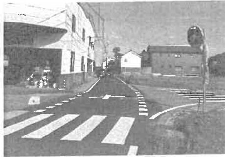
鴨島・県道西麻植下浦線 (上浦・舗装修繕)
