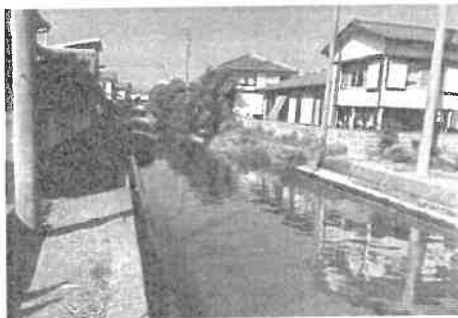
鴨島・江川 (繁茂していた水草の撤去)
