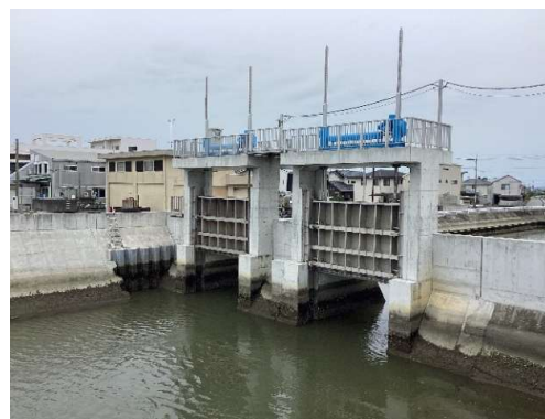
樋門改修完了(松茂町 喜来地区)
