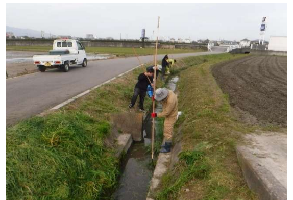
水路環境の保全活動(徳島市)
