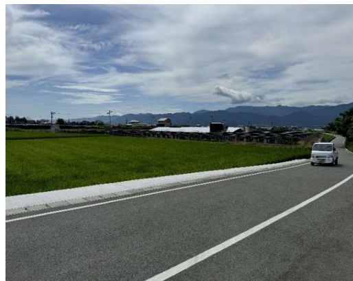
整備が完了した農道(阿波市 伊沢中央2期地区)
