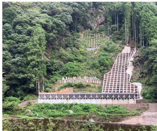
工事完了(山腹工)
