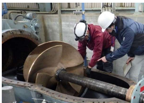
排水機 改修状況(鳴門市 恵美寿地区)
