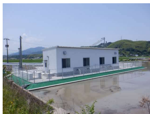
揚水機場(那賀川・小松島地区)
