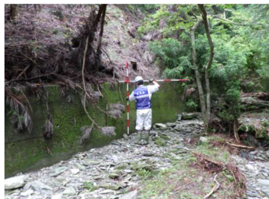
治山施設の点検状況
