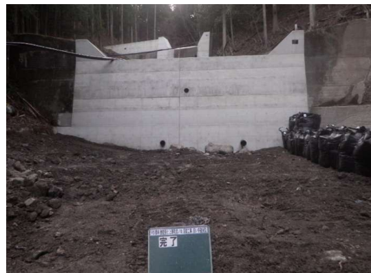
工事完了(治山ダム工)
