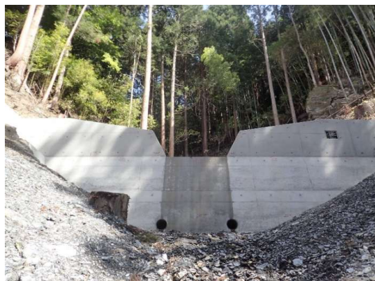
工事完了(治山ダム工)
