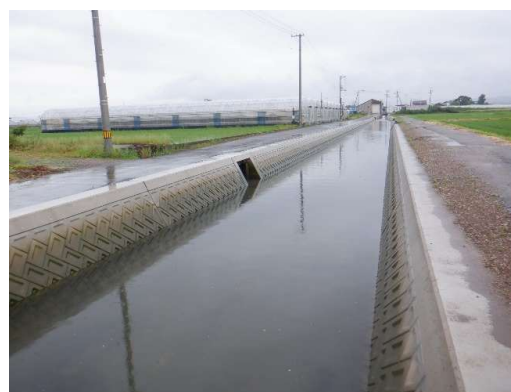
用水路補修(那賀川・小松島地区)
