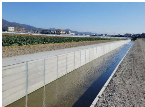
改修後の排水路(阿波市 古毛川排水路地区)
