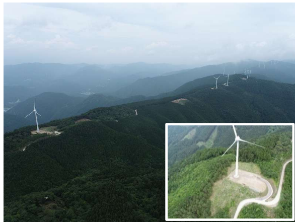
風力発電施設の設置及び管理にも利用されている林道 大川原旭丸線(上勝町)
