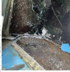
浄水場沈没池の躯体ひび割れ
