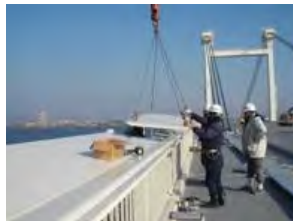
高欄にフラップ 設置
