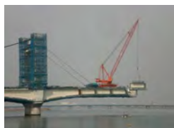
1 段目仮ケーブル
