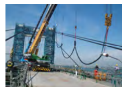
側径間斜ケーブル架設
