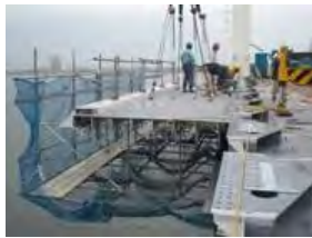
架設時の耐風安定のため、 車道床版と歩道部床版を 同時架設
