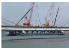
水平ケーブル架設
