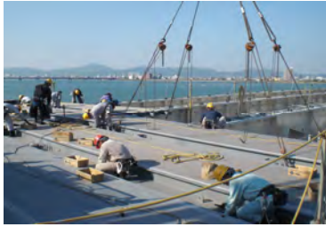
サト・イチ床版架設
