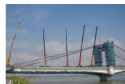
側径間斜ケーブル架設
