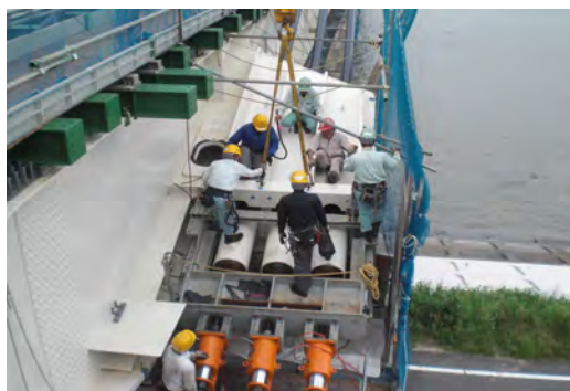
ケーブル緊張時(1000 t ジャッキ)
