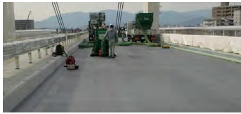
鋼板と防水層の密着性を高める ため表面を研掃
