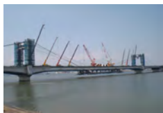
中央斜ケーブル架設
