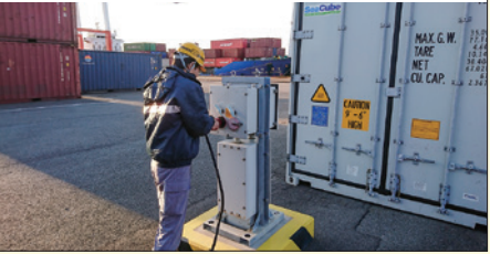
冷凍コンテナ用電源 Power supply to Reffer container
