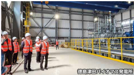
徳島津田バイオマス発電所
