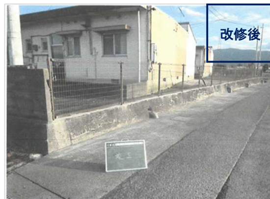
阿波市（杉ノ前団地）において撤去と新設事業を実施
