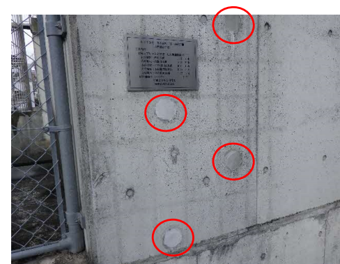
せん断補強鉄筋 （右岸堰柱・門柱基部4本）の施行(R7)
