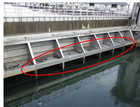
横桁補強（ステンレス板）の施行(R7)
