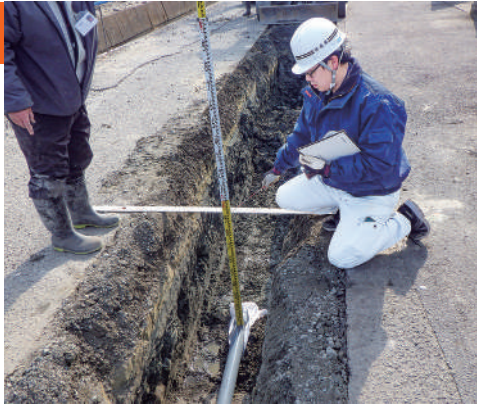
▼ 管の埋設深さ確認の様子
