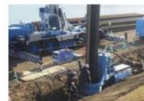
油圧圧入引抜工
