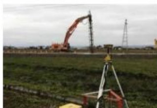
中層混合処理工（ICT）
