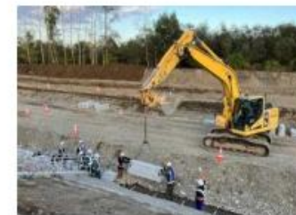
護岸基礎ブロック据付工
