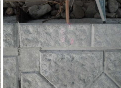
②完成状況(粗面ブロック設置完了)
