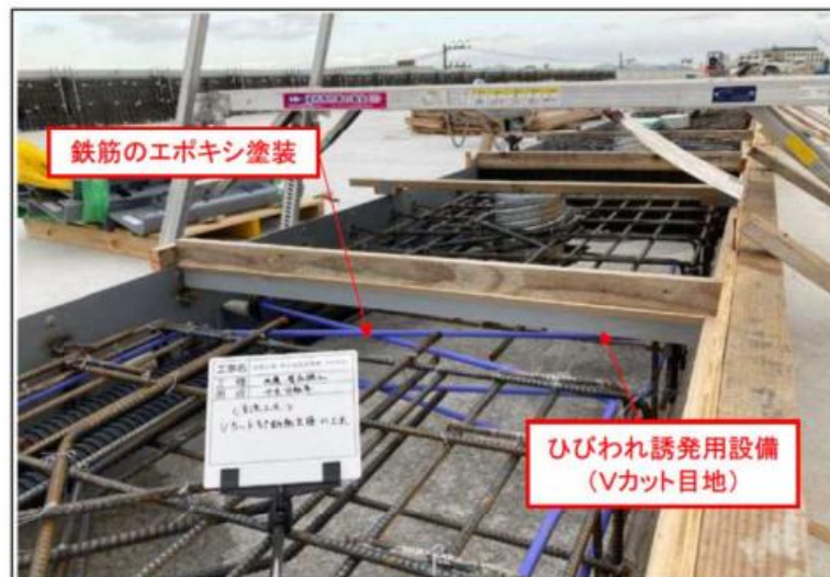
中央分離帯へのVカット目地の設置
