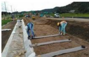
排水材設置工（水平排水層）
