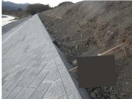
①完成状況(粗面ブロック設置完了)
