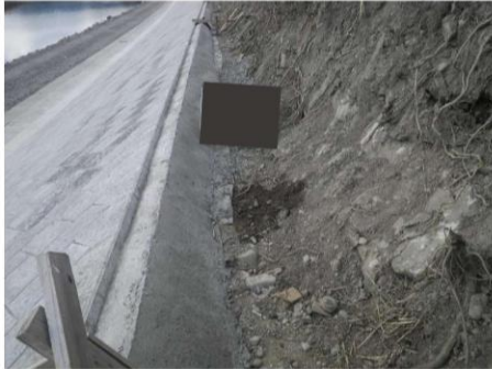
③粗面ブロック面板設置前(天端コンクリート完了時)
