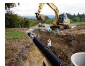
排水構造物工（暗渠排水管）
