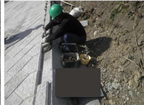
④粗面コンクリート面板設置状況
