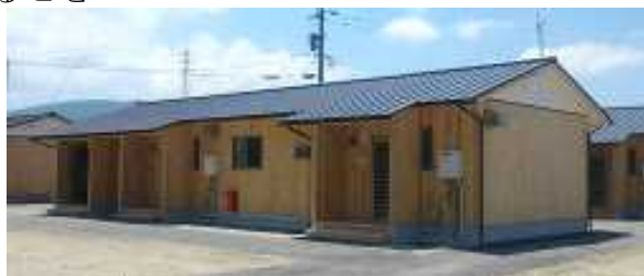
木造応急仮設住宅
