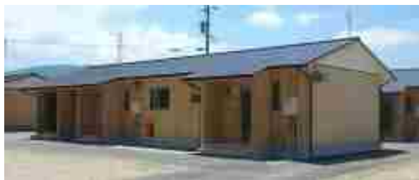
木造応急仮設住宅
