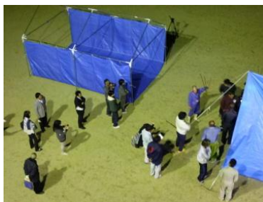
仮設テントの設営
