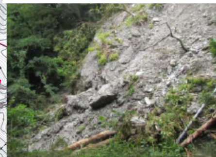
⑤平成30年7月豪雨による 末端部の崩壊
