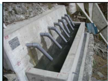
横ボーリング工
