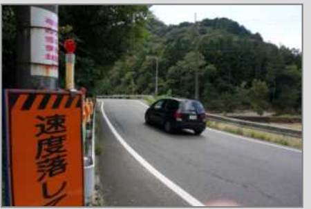
幅員狭小・視距不足
